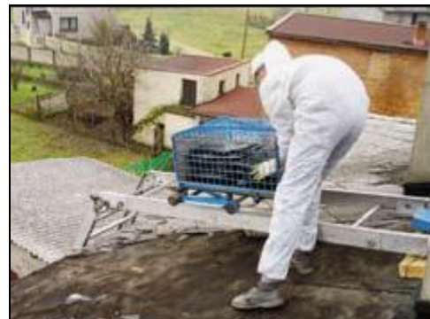
Transport mechaniczny za pomocą wyciągu dekarckiego.
