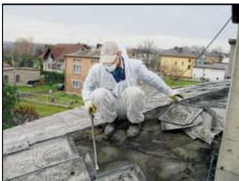
Demontaż płyt eternitowych w całości za pomocą narzędzi ręcznych.
