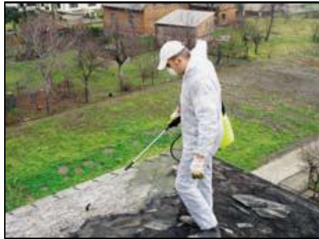
Nawilżanie płytek dachu wodą za pomocą spryskiwacza.
