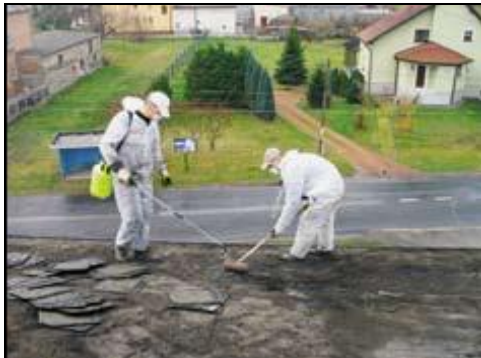
Oczyszczenie terenu prac z pozostałości eternitu poprzez zmiatanie na mokro.
